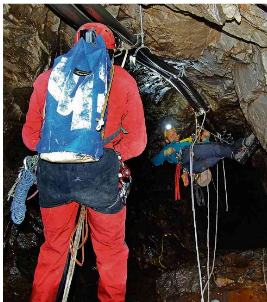
Der Bergführer Daniel Vonwiller (r.) aus Aarburg bei den harten Montagearbeiten im Stollen.
