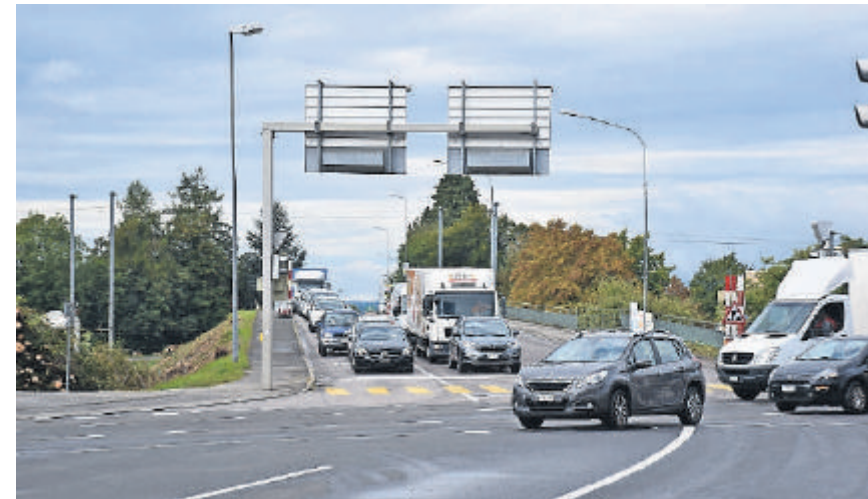
Blick Richtung zu ersetzende SBB-Brücke: Die Arbeiten beginnen am Montag. (FUP)
