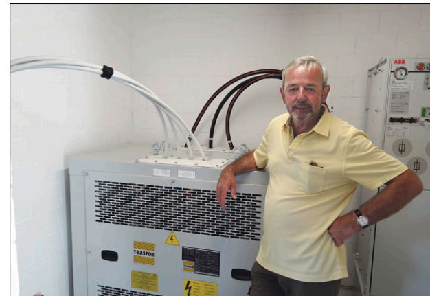
Baustellenchef Ernst Stalder im Trafo-Raum in der Vermigelhütte.
