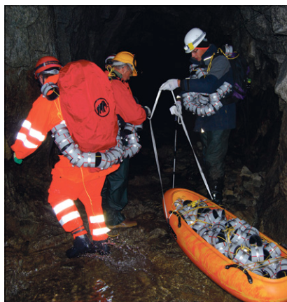
Während der Bauarbeiten: Das Kabel wurde in einen bestehenden SBB-Wasserstollen verlegt.
