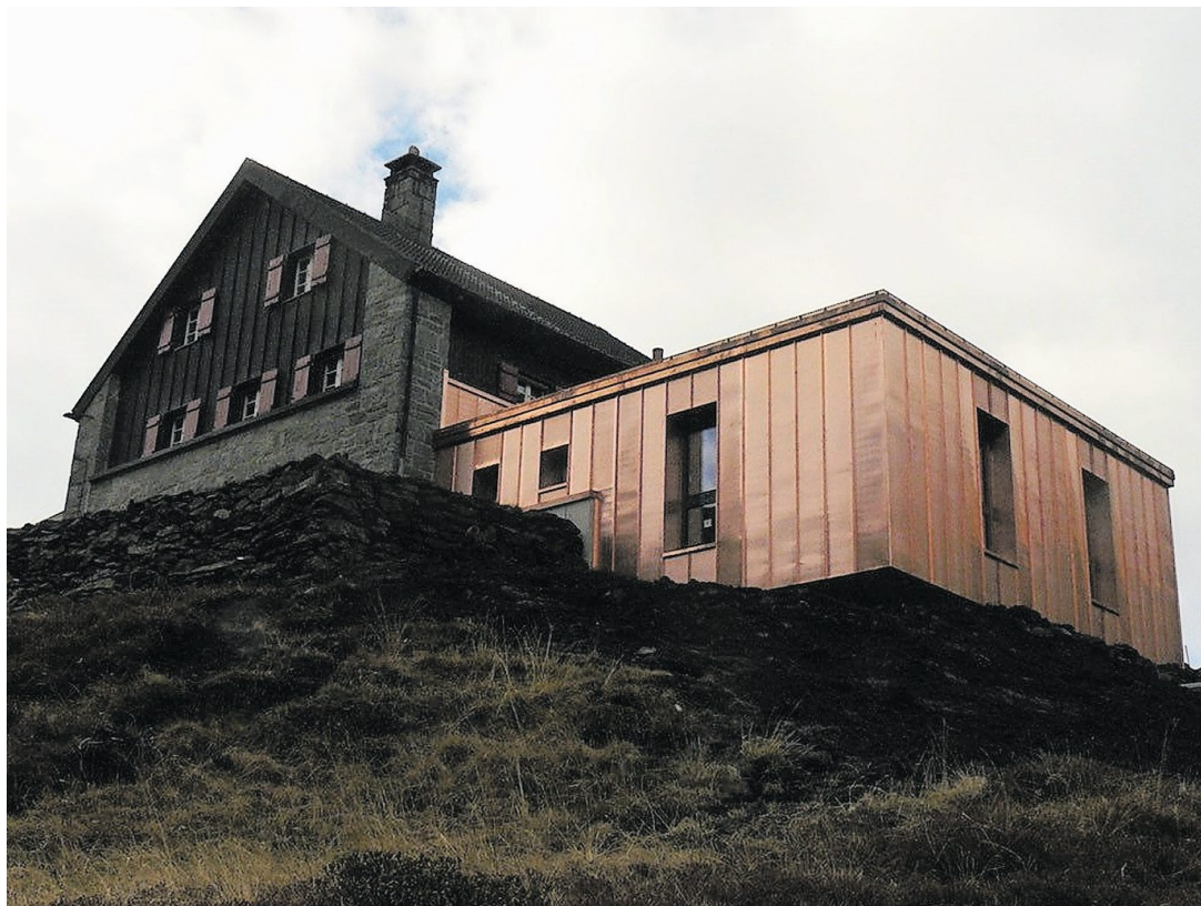
Die Vermigelhütte der SAC-Sektion Zofingen wurde erweitert.
