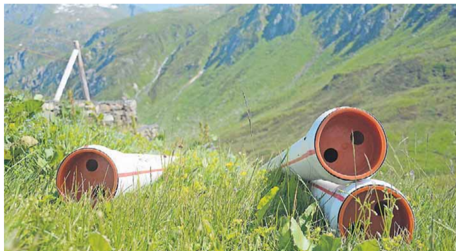
Über 800 Meter Wegstrecke gilt es derzeit diese Rohre in den Boden zu bringen.
