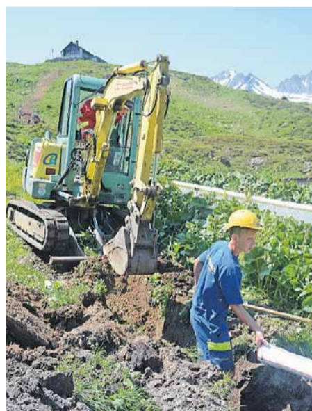
Die Lernenden verlegen die Rohre bis zur Hütte im Hintergrund hinauf ...
