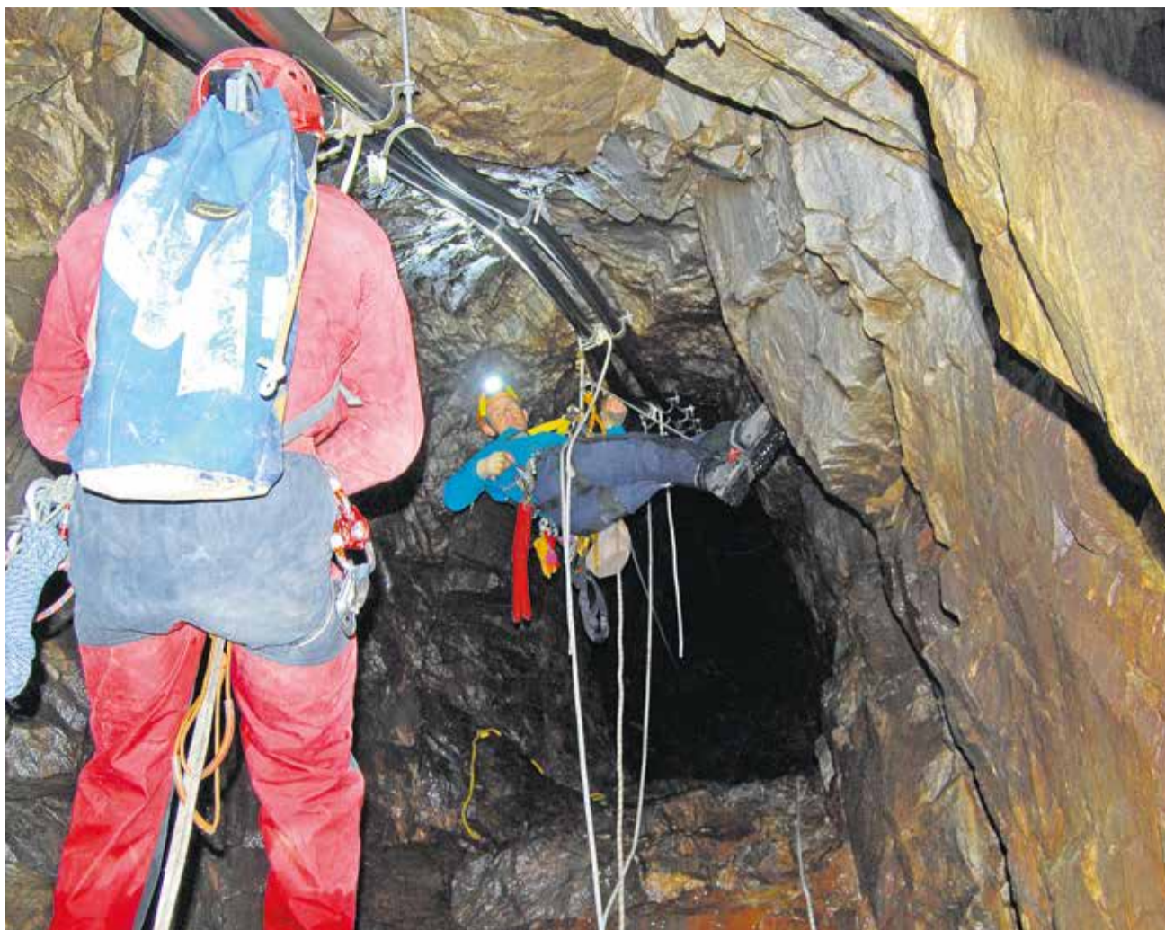
Harte Montagearbeit unter Tag: Die elektrische Hauptschlagader, das knapp zehn Kilometer lange und 17 Tonnen schwere Mittelspannungskabel, wurde in zwei Wasserstollen verlegt. Foto zvg
