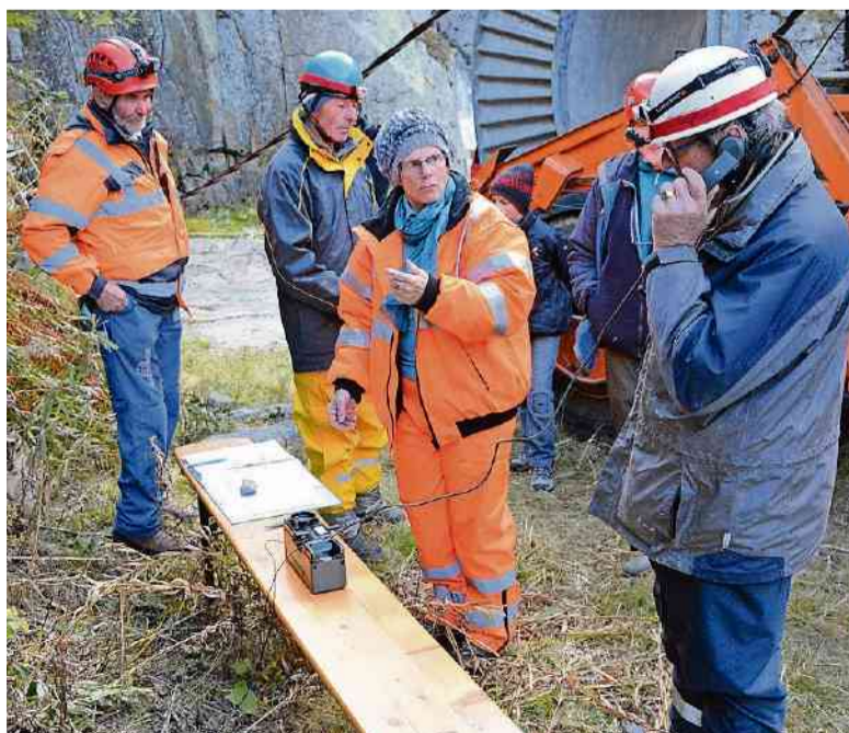
«Ist alles bereit?» Bauleiter Ernst Stalder vom SAC Zofingen telefoniert vor dem Startschuss sämtliche Posten im 4,5 km langen ersten Tunnel ab. MIF
